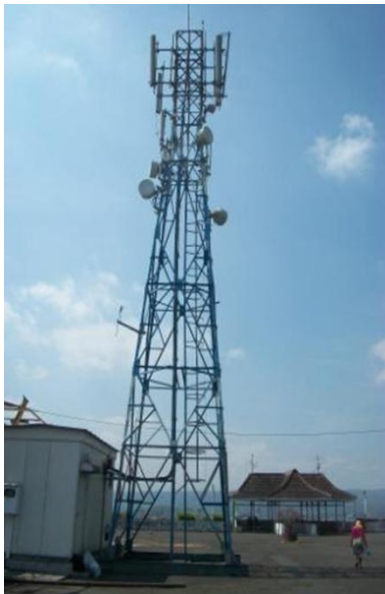
Gambar 1.1. Tower Diatas Atap Sebuah Gedung
